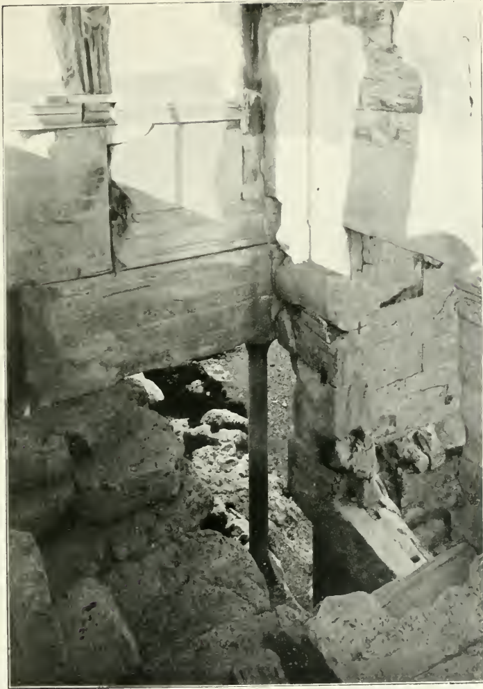
L'EMPLACEMENT DU GÉCROPION. Vue prise de l'intérieur du Portique des Cores.
